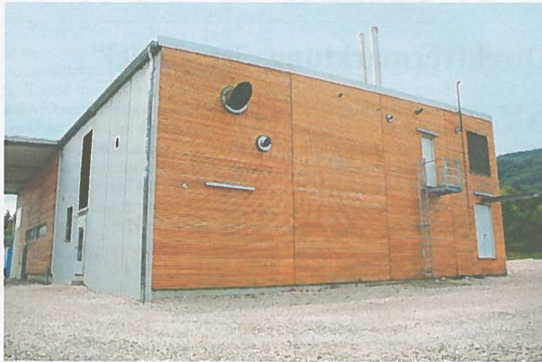
Moderner Bau: Das Biomasseheizwerk Hersbruck.
