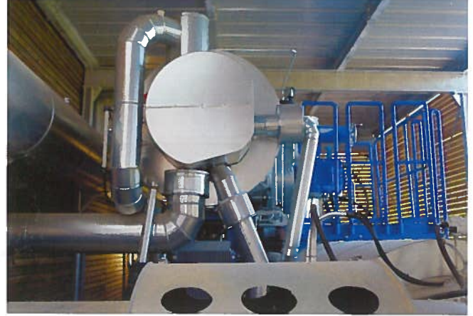
Um aus der Wärme des Holzvergasers Strom zu erzeugen, wurde eine ORC-Turbine installiert. Fotos: Wraneschitz
