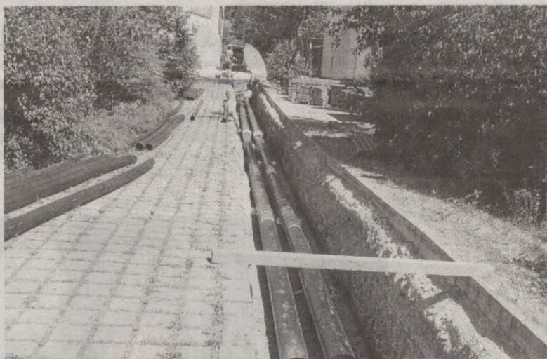
Mitte vergangenen Jahres verlegte die Hewa die Fernwärmeleitung, die das Gymnasium mit dem Heizkraftwerk der Naturenergie in der Am-
