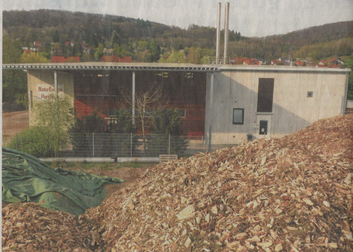
Das Hackschnitzel-Heizwerk samt Stromgewinnung in der Amberger Straße trägt zur überdurchschnittlich guten Bilanz Hersbrucks bei den erneuerbaren Energien bei.
